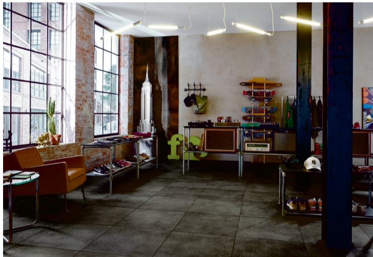
Das fertige Werk eines Plattenlegers: Hier geben Keramikplatten dem Laden den letzten Schliff.
