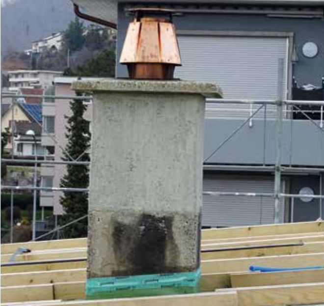
Der Kamin wurde verlängert: mindestes einen Meter über den Dachfirst.
